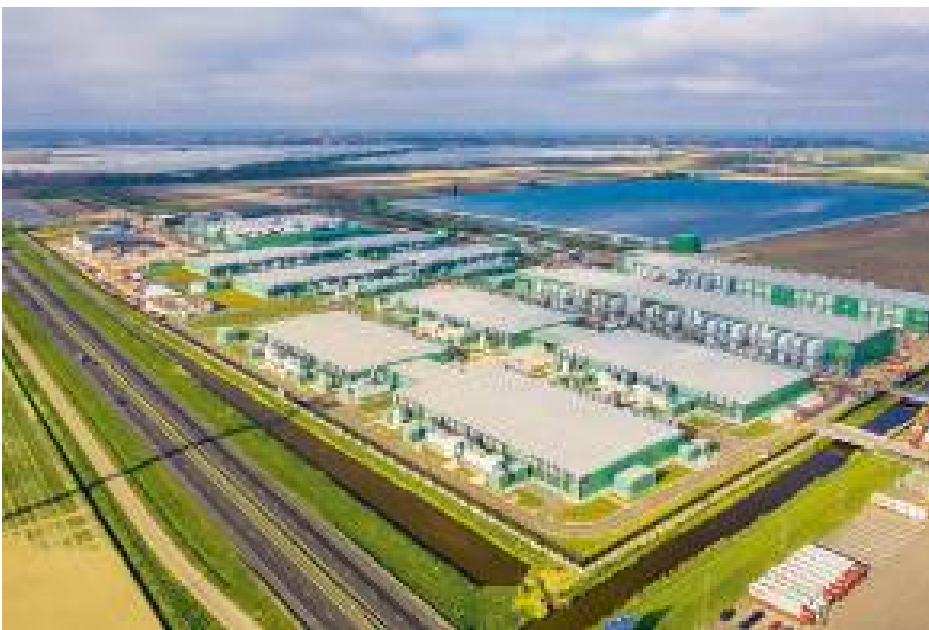
Google datacenter in Hollands Kroon, in het noorden van Noord-Holland. De enorme hoeveelheid afvalwarmte wordt gebruikt om de kassencomplexen rondom te verwarmen.
